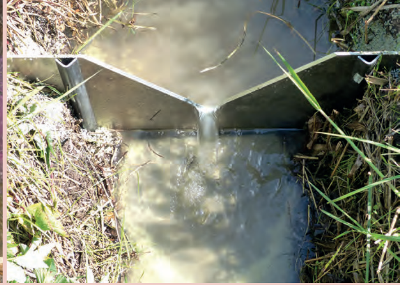
▼ Grundwassermessstelle beim Mühlbach
