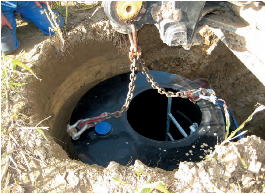
Im Boden bis 1,2 m Tiefe versenkte Boden-Monitoring-Station (Lysimeter)
